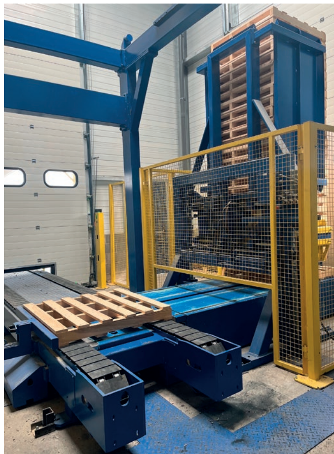
Magazyn drewnianych palet jest dostępny od zewnątrz dla ułatwienia pracy oraz bezpieczeństwa personelu.
