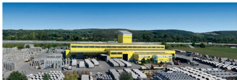
Zakład produkcji rur i studni HABA-Beton w Nussdorf pod Wiedniem otwarty w 1998 roku.
