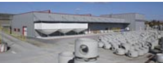
Stradal uruchomił niedawno w swoim zakładzie w Kilstett drugą linię produkcji podstaw studni w technologii Perfect.
