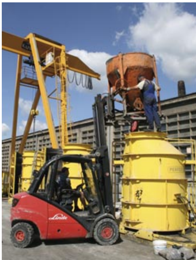
Zalewanie betonem następuje za pomocą wózka widłowego i silosu. Tak jak systemie Perfect stosowany jest wyłącznie beton samozagęszczalny SCC.
