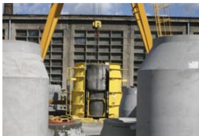
Po odpowiednim czasie formy są otwierane, a kręgozwięzka ostrożnie wyjmowana przy pomocy suwnicy.
