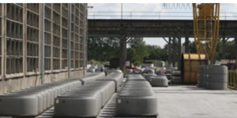
Kaprin produkuje kręgi betonowe na zainstalowanej w 2001 r. maszynie Precise firmy Schlüsselbauer.
