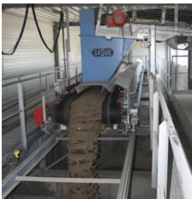
Z przenośnika kubetkowego kruszywa trafiają za pośrednictwem taśmociągu rozdzielczego do jednej z ośmiu betonowych komór silosu.
