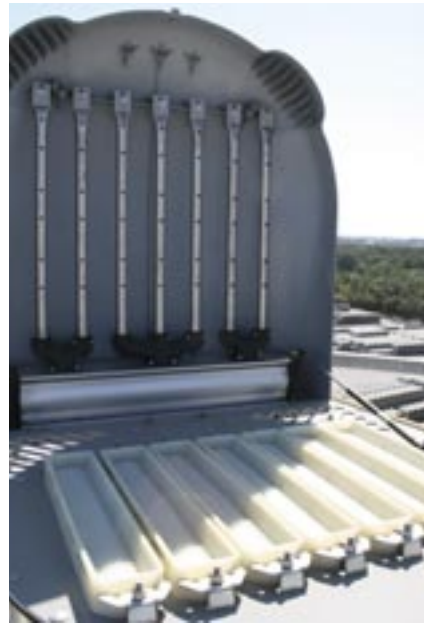
Filtr gwarantuje, że zawartość cząstek w powietrzu wynosi mniej niż 20 mg/m 3 .
