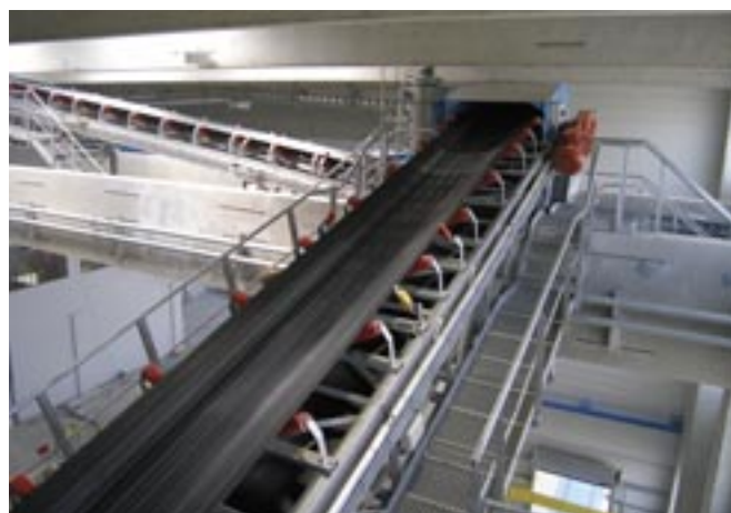
Od miejsca dozowania aż do węzła betoniarzkiego kruszywa transportowane są za pomocą dwóch długich taśmociągów o szerokości 1200 mm.
