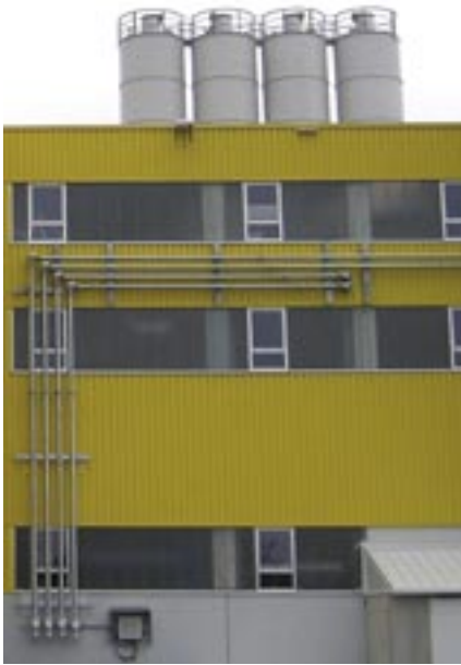
Cztery silosy cementu mają pojemność po 85 ton.
