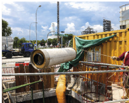
Wszystkie zalety rur betonowych – wysoka wytrzymałość statyczna i odporność na uszkodzenia podczas manewrowania wyrobem – są w rurze Perfect Pipe o grubości ścianki 130 mm nadal zachowane.
