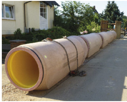
Pierwszy projekt w mieście Hesse (Niemcy) - zastosowana została rura Perfect Pipe DN800.
