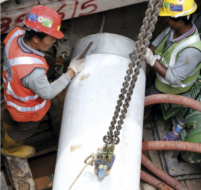
Opuszczanie rury do studni startowej.
