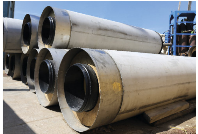
Magazyn rur przeciskowych Perfect Pipe na budowie.
