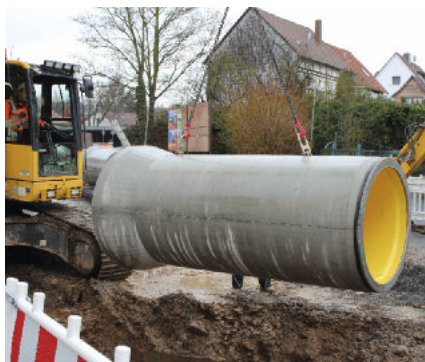
Rura podwieszona na zawieszach za pomocą dwóch zintegrowanych kotw.
