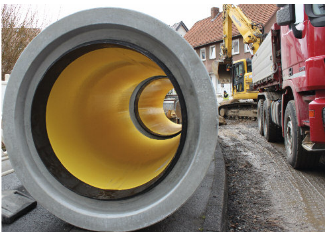
Magazyn na placu budowy w Sanderhausen, gmina Niestetal – żelbetowa rura Perfect Pipe DN1000 wyposażona na etapie produkcji we wtykowy konektor.
