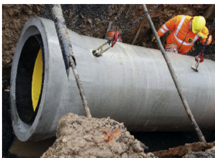
Opuszczenie rury do wykopu i wtykowe łączenie z istniejącym rurowciągiem.
