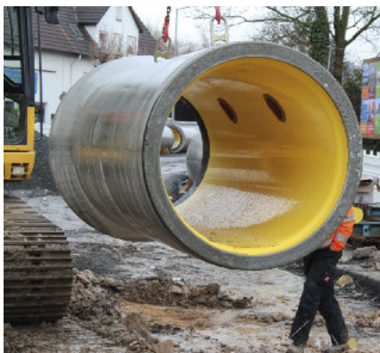
Podnoszenie gotowej do instalacji rury Perfect Pipe z dwoma bocznymi wlotami.
