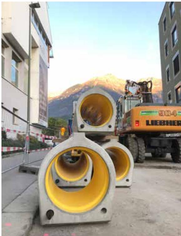
Die breite Auflagefläche des Fußrohres gehört zu den Vorteilen.
