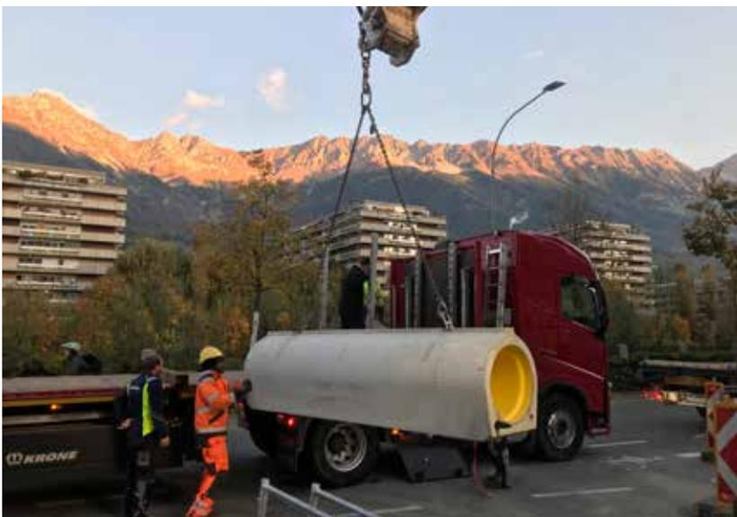
waren sowohl von der einfachen Steckverbindung als auch von der Verlegefreundlichkeit der Betonfußrohre beeindruckt. Trotz aufwändiger innerstädtischer Einbaubedingungen ging der Einbau dank der robusten, einfach zu verlegenden Rohre rasch voran.
