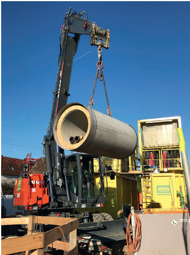
Bild 2. Das nächste 2-m-Rohr DN 700 mit Druckübertragung und einbetoniertem Edelstahl-Führungsring wird in die Startgrube eingehoben (Quelle: SCHLÜSSELBAUER Technology)
