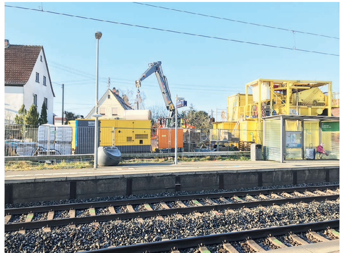
Bild 3. Baustelle rund um und unter dem Gleisbereich: Überdeckung von 2,7 bis 3,2 m – für in terra Microtunneling gewohntes Terrain (Quelle: SCHLÜSSELBAUER Technology)
