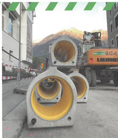
Die mit der Ausführung befassten Mitarbeiter des Bauunternehmens Swietelsky waren sowohl von der einfachen Steckverbindung als auch von der Verlegefreundlichkeit der Betonfußrohre beeindruckt.
