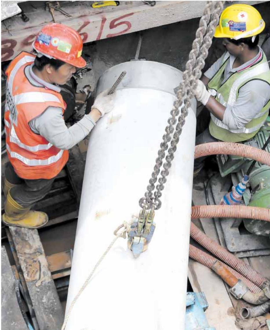
Einheben des Rohres in den Startschacht: Singapurs Hersteller von Betonrohren, Bilcon, setzt auf Schlüsselbauer Technology.
