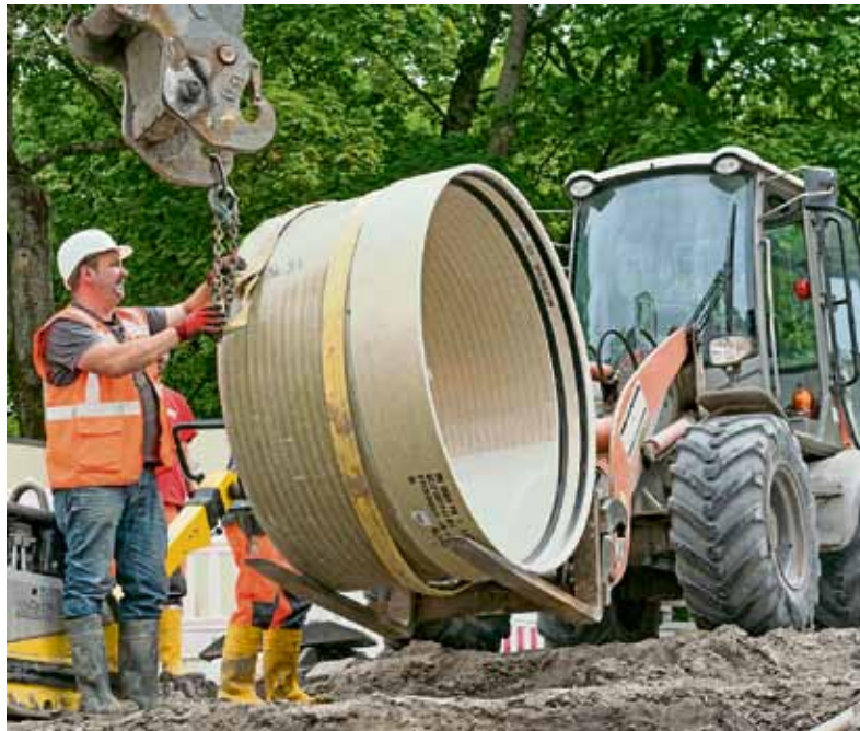
Die Profilierung trägt dazu bei, dass Frachtstoffe auch bei geringen Abflussmengen befördert werden und eine mögliche Geruchsbelastung weitestgehend vermieden wird.
