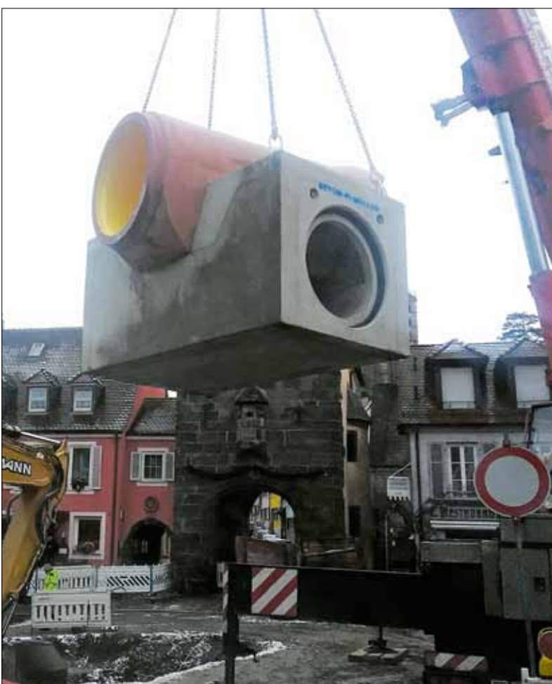
Sämtliche Betonbauteile wurden in Breisach von Beton Müller geliefert.
