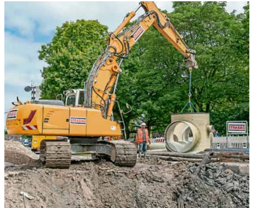
Neben den GFK-Rohren wurden fünf große Schachtbauwerke im Bereich der Mitscherlichstraße neu gesetzt.
