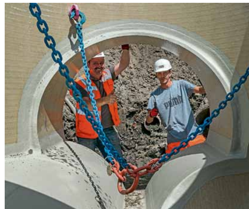
Auch die GFK-Schachtbauwerke wurden in einem Stück gefertigt. Ihre Ausgestaltung und Funktionalität richtet sich nach den Erfordernissen am Einsatzort.
