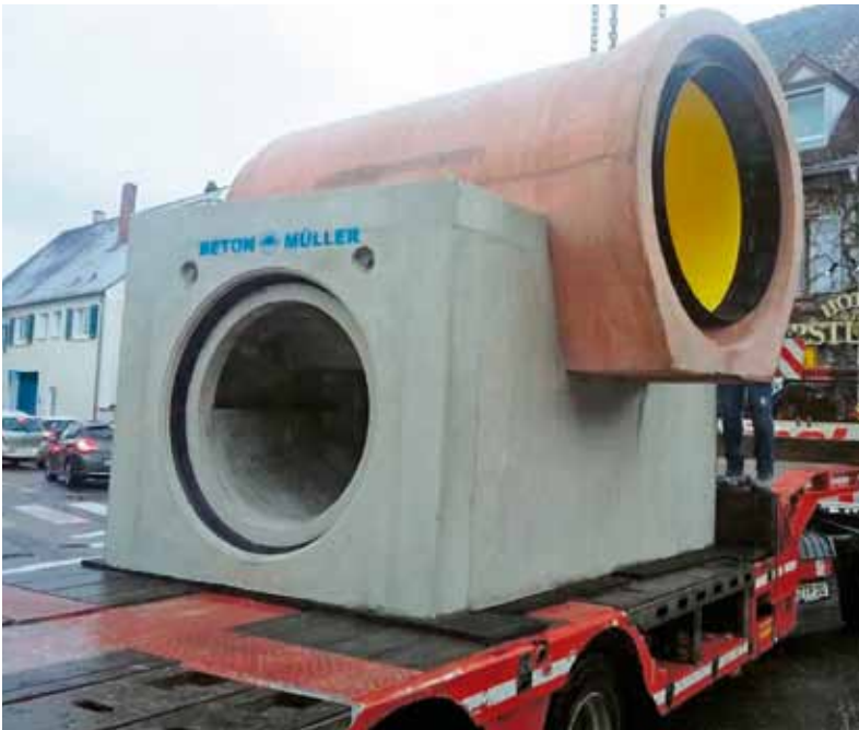
Neben den Perfect Pipe-Rohren wurden in Breisach auch mehrere Sonderbauteile verwendet, die ebenfalls aus der Produktion von Beton Müller stammen.
