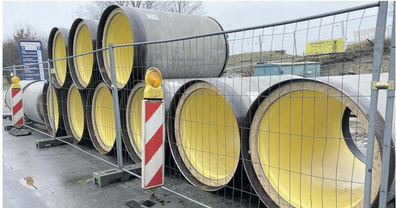
Die Rohre haben eine Auskleidung aus hochverdichtetem Polyethylen (HDPE).
