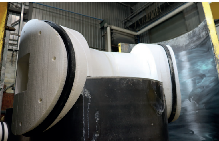
Die fertigen Negativgerinne werden mittels Magnettechnik fixiert.
