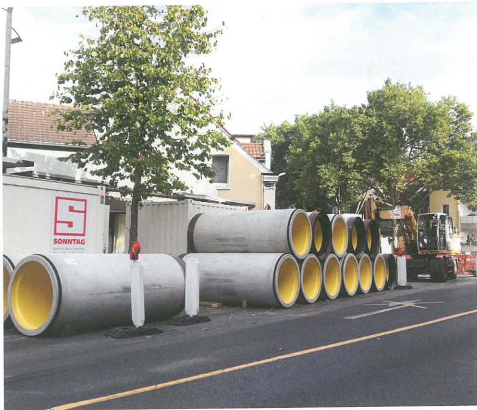
Bild 1 Projekt Datteln, Nordrhein-Westfalen, Deutschland: Baustellenlager Perfect Jacking Pipe DN1200 von Beton Müller.
