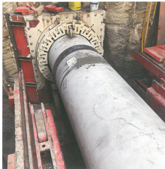
Bild 3 Die Leitungen mit Nennwerten von 700 mm sind ein wesentlicher Teil-Abschnitt in der Kanalisation Medernachs.
