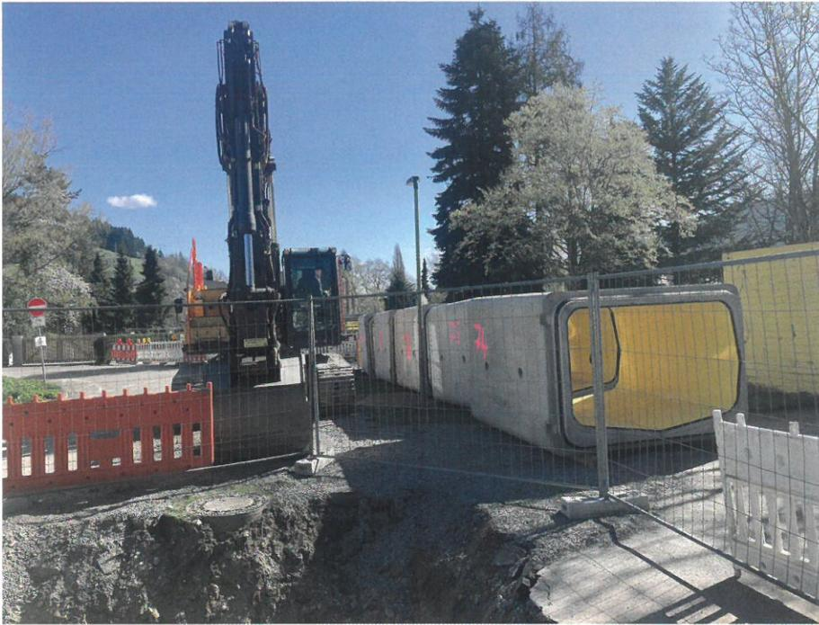
Für das Versetzen der 11,2 Tonnen schweren Rahmenprofile kam ein 60-Tonnen Bagger zum Einsatz. Das Verlegen des Systems mit Inliner und der Rohrverbindung mit einer speziellen Dichtung hat einwandfrei funktioniert.
