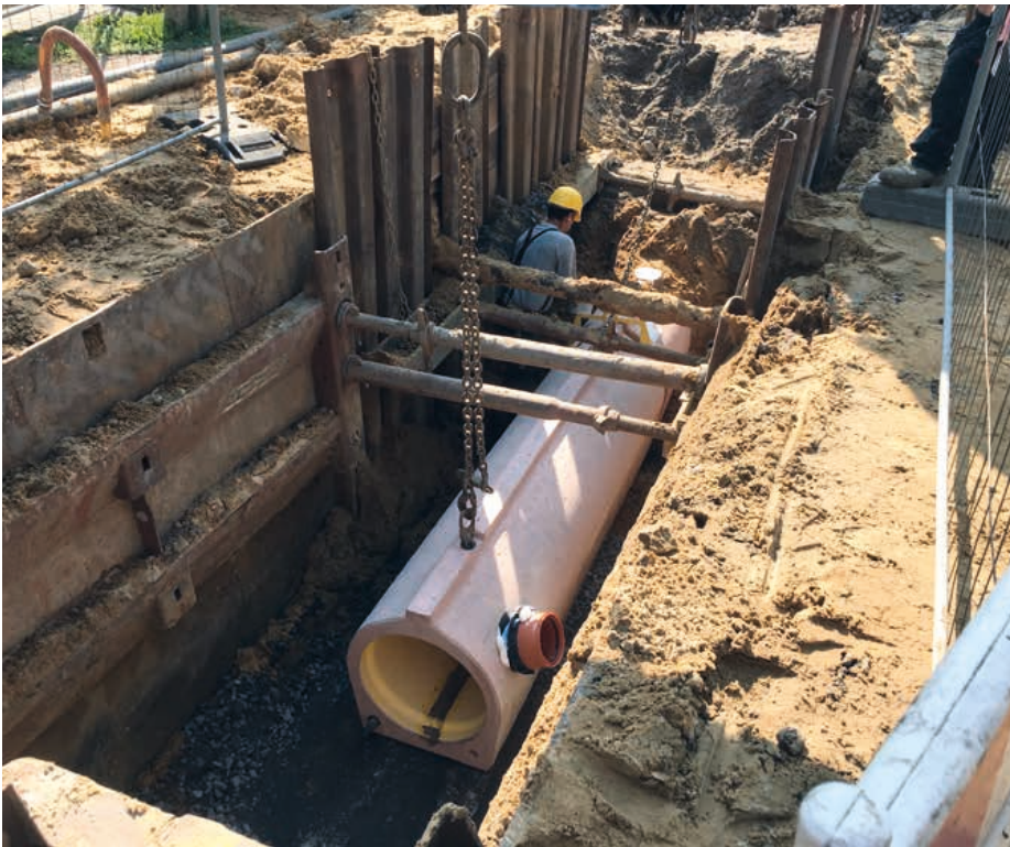
Einbindung eines Hausanschlusses mit dem Fabekun Sattelstück. | Foto: Thomas Palz, SAL
