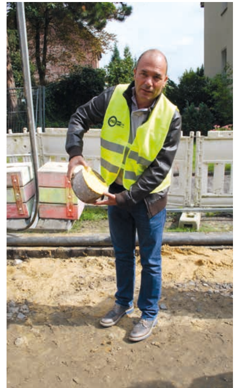
Joachim Strack mit dem Kern einer Bohrung zum Herstellen eines Hausanschlusses: „Der Liner ist beim Anbohren der Rohre unproblematisch.“ | Foto: A. zu Eulenburg
