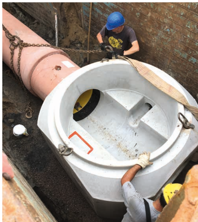
Die von Berding gelieferten monolithischen Schächte sind mit dem Rohrsystem voll kompatibel. | Foto: Thomas Palz, SAL
