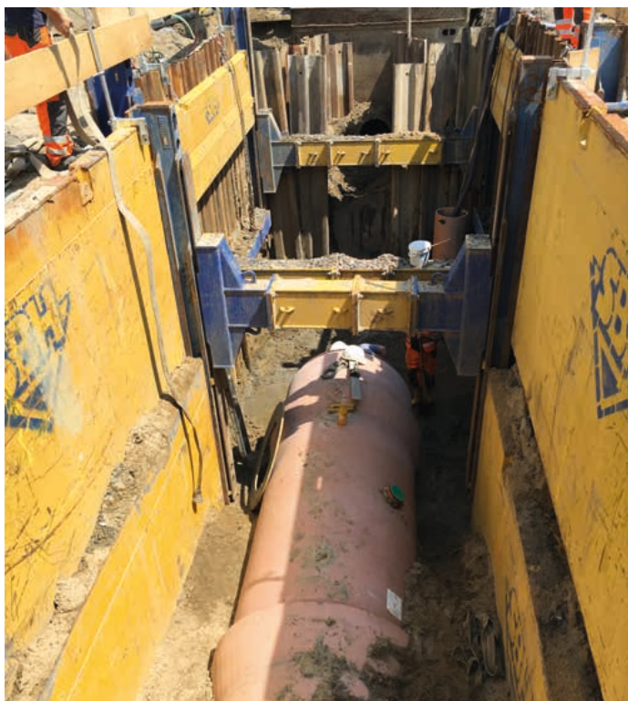
Die Verlegeeigenschaften der Rohre werden auf den Baustellen in Lünen durchweg gelobt. | Foto: Michael Gebhard, Strabag
