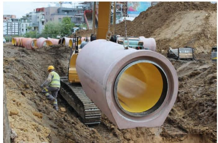
Die Rohrverbindung mit dem innen liegenden Perfect Connector erlaubt auch eine „Rückwärtsverlegung“ in Fließrichtung.
