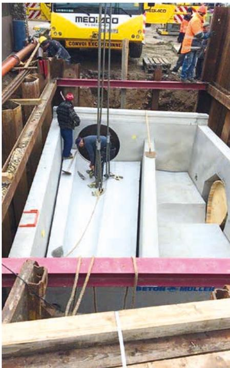
In dem vom Betonwerk Müller hergestellten Trennbauwerk verjüngt sich das Gerinne und an den Auslauf schließt der weiterführende Kanal DN 500, ebenfalls aus Perfect Pipe, an. | Foto: Betonwerk Müller
