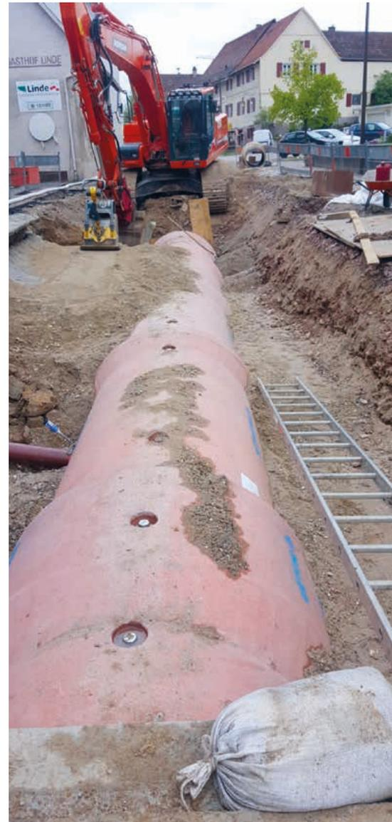
Die Verlegung des Fußrohres erspart die Zwickelverdichtung. In Achern spielten bei der geringen Überdeckung auch die statischen Vorteile von Perfect Pipe eine Rolle. | Foto: Huber-Bau
