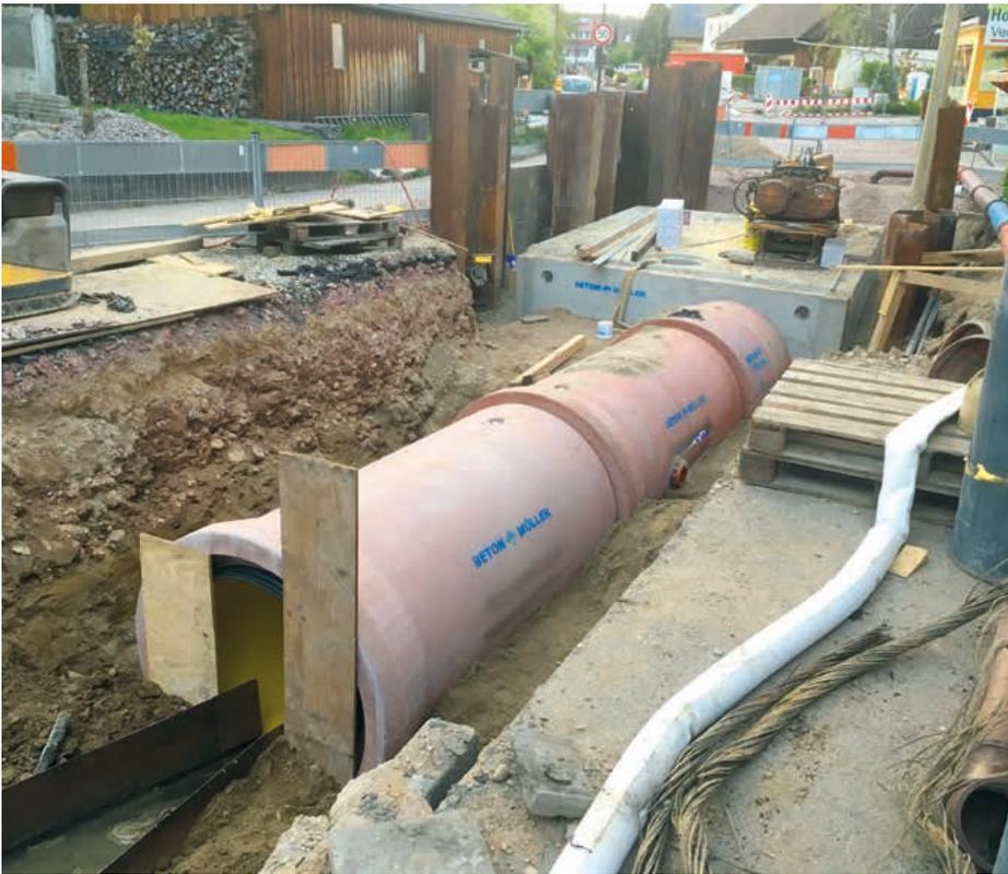
Der 1200er Kanal mündet in ein neues Trennbauwerk. | Foto: Betonwerk Müller
