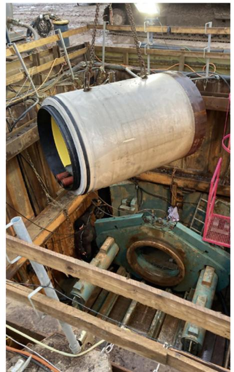
Perfect Jacking Pipe-Rohre sind mit zwei Kugelkopfankeern im Rohrscheitel versehen und konnten mit Kugelkopfabhebern sicher abgeladen und in die Startgrube abgelassen werden. | Foto: Müller Beton
