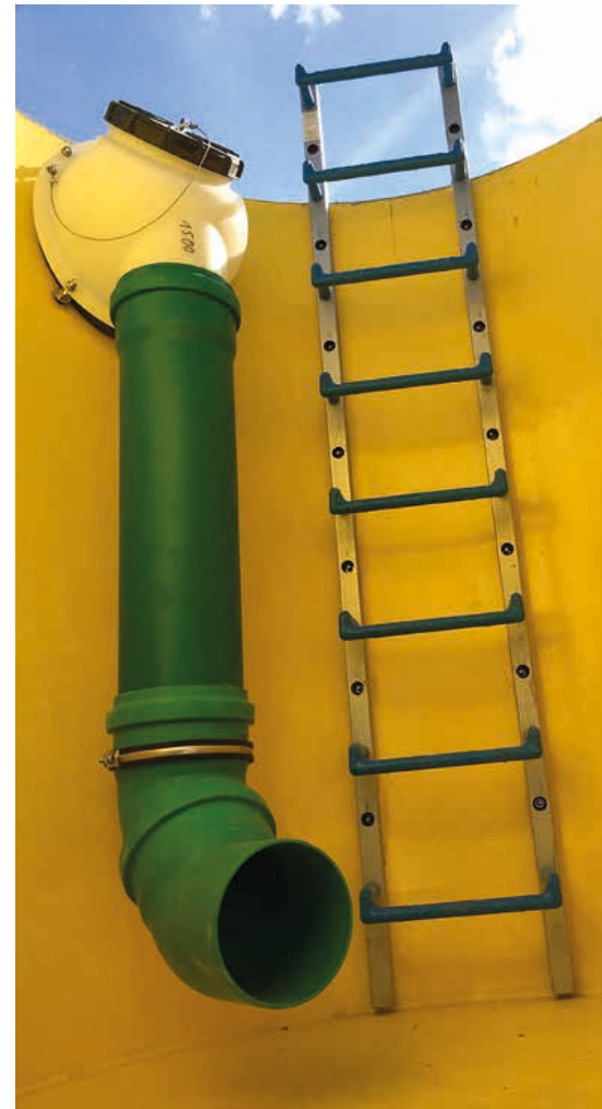
... Absturz und Leitern wurden mit O-Ringen abgedichtet, um eine Hinterläufigkeit beim PE-Liner auszuschließen. | Foto: Beton Müller
