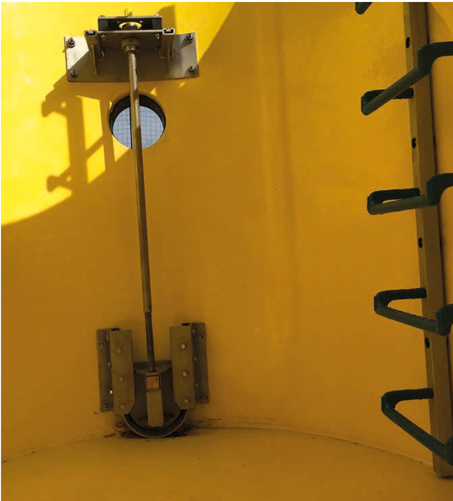
Die Verankerungen der Schachteinbauten wie Schieber, ... | Foto: Beton Müller
