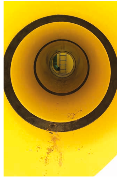
Blick in den fertig verlegten Staukanal. | Foto: Beton Müller
