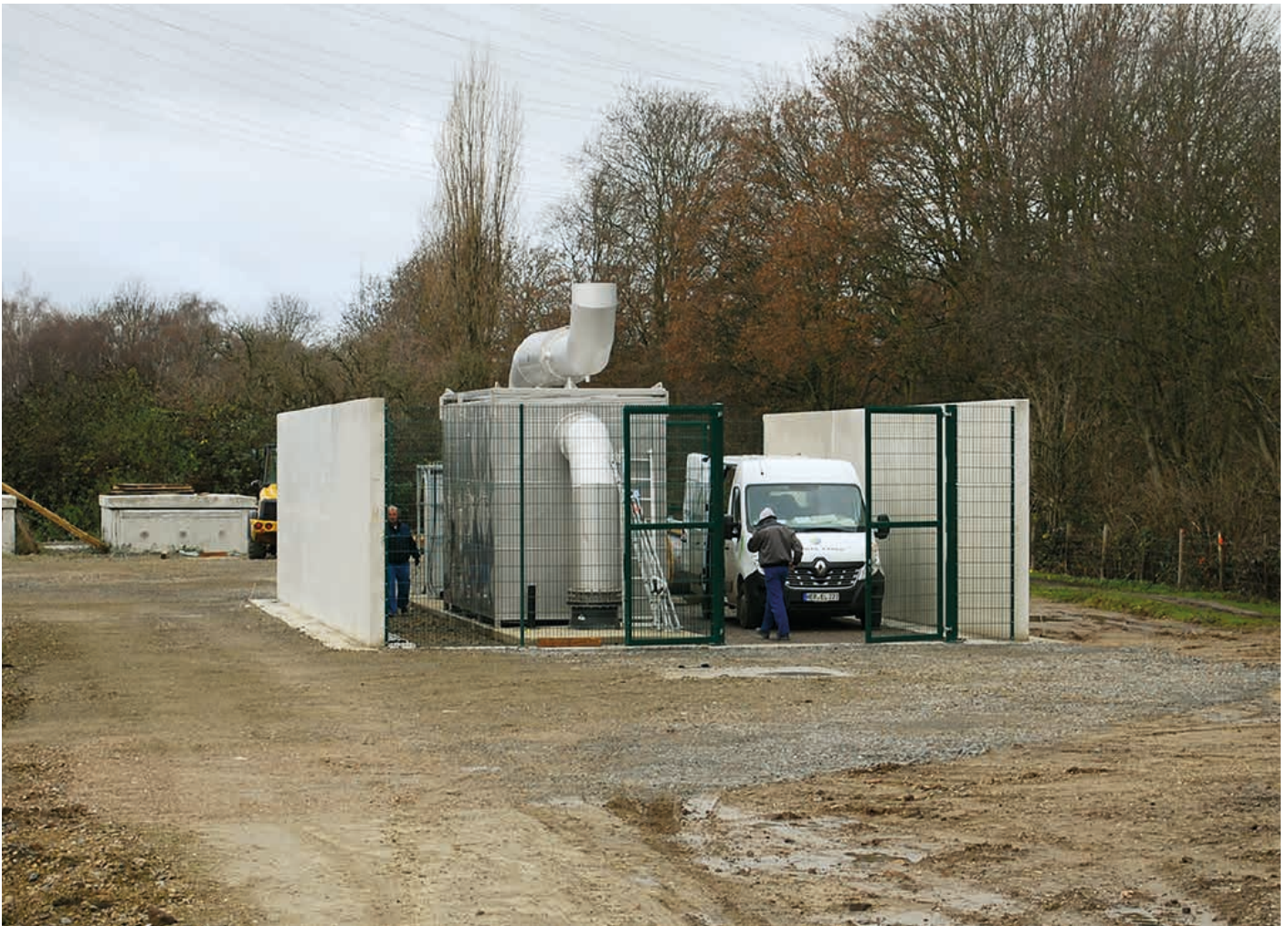
In dieser Belüftungsanlage wird Luft aus dem Kanal gesaugt und gereinigt. | Foto: A. zu Eulenburg
