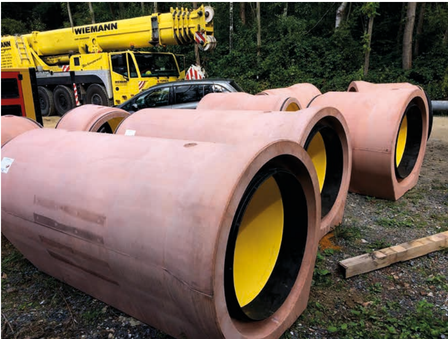
Für den Staukanal wurden mit PE ausgekleidete Perfect Pipe-Rohre DN 1000 verwendet. Das spezielle Dichtungssystem stellt neben der Dichtheit auch den lückenlosen Korrosionsschutz der Rohre sicher. | Foto: Beton Müller
