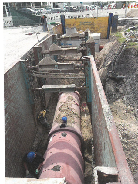
Bild 3. Eine 80 m lange Haltung wurde mit Perfect Pipe-Rohren DN 1000 erneuert.
