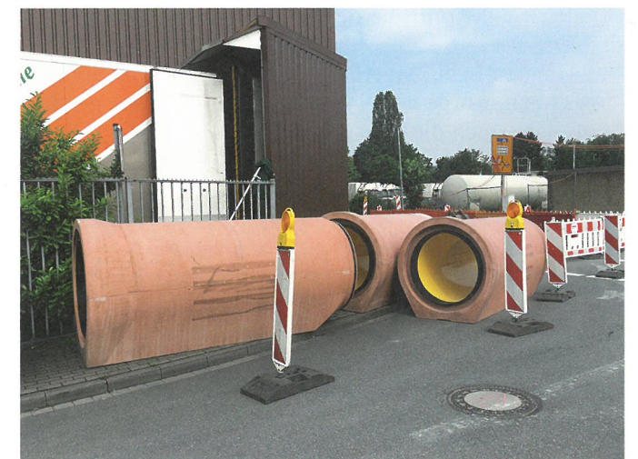
Bild 6. Die Herstellung des Planums für das Rohraufleger erfordert wegen der breiten Auflagerfläche des Fußrohres etwas mehr Sorgfalt, dafür entfällt die kritische und aufwändige Zwickelverdichtung. (Fotos: Beton Müller)
