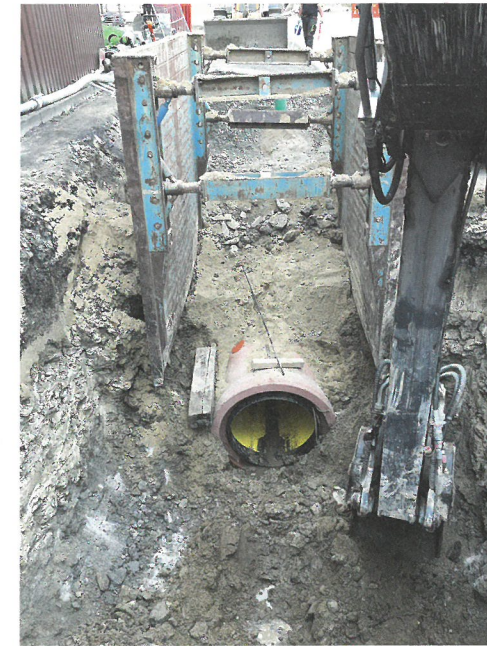
Bild 4. Schwieriger, felsiger Baugrund.
