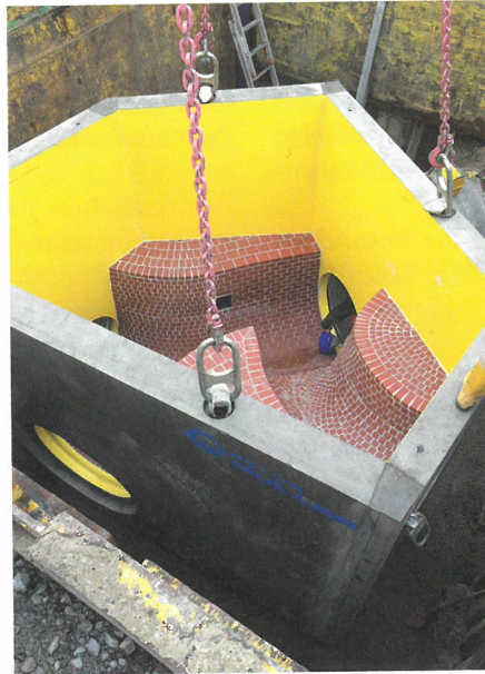
Bild 2. Versetzen des Fertigteilbauwerkes in die Baugrube.
