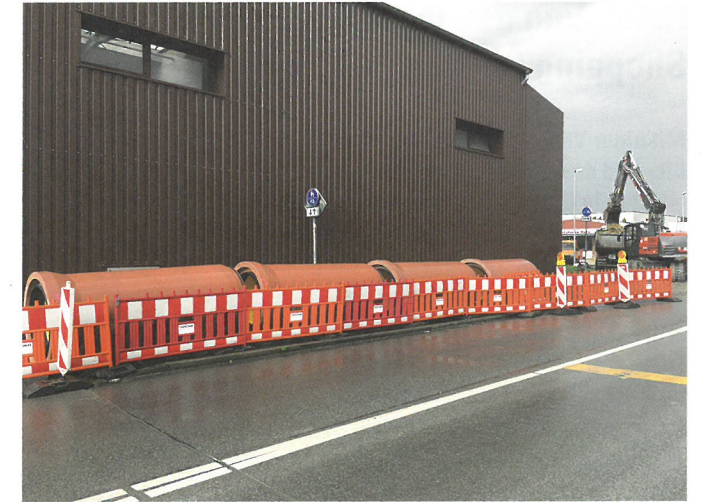
Bild 5. Im Umfeld der Baustelle stand wenig Platz zum Lagern der Rohre zur Verfüllung.
