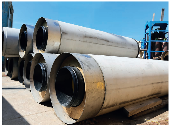
Bild 2. Zwischenlager von Perfect Pipe Vortriebsrohren an der Baustelle (Fotos: SCHLÜSSELBAUER Technology)
