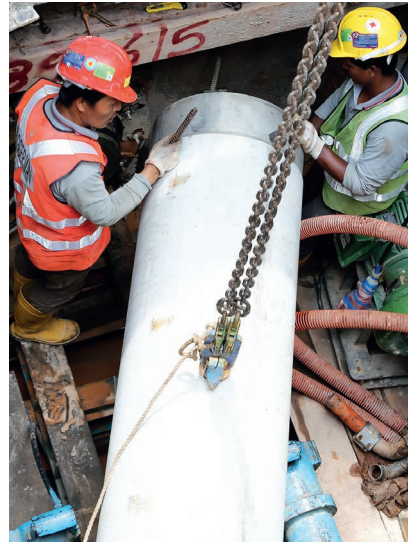
Bild 1. Einheben des Rohres in den Startschacht
