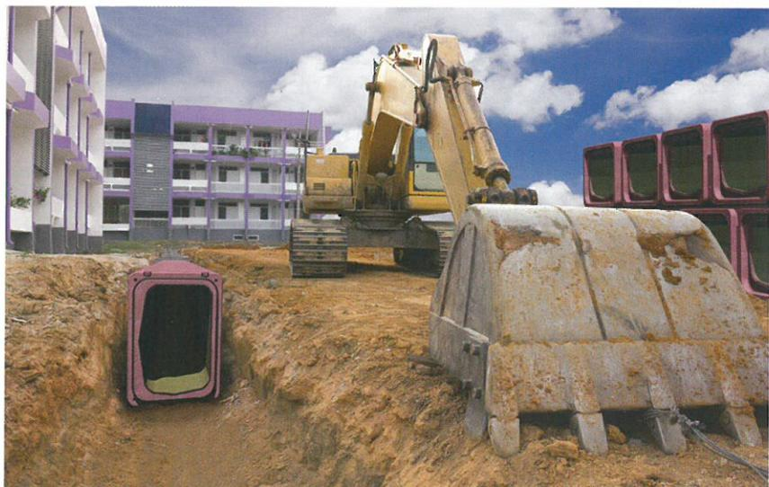
**Bild 2:** In einem schmalen Graben kann die Perfect Box hochkant eingebaut werden, um einen größeren Abflussquerschnitt zu erlangen
