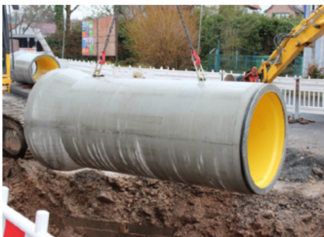
Bild 3: Einheben in die Baugrube unter Zuhilfenahme eines an zwei Kugelkopfankefarn befestigten Kettengehänges
