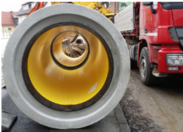
Bild 1: Perfect Pipe-Stahlbetonrohr DN 1000 mit werkseitig integriertem Kunststoff-Steckverbinder kurz vor dem Einbau auf der Baustelle in Sandershausen, Gemeinde Niestetal
