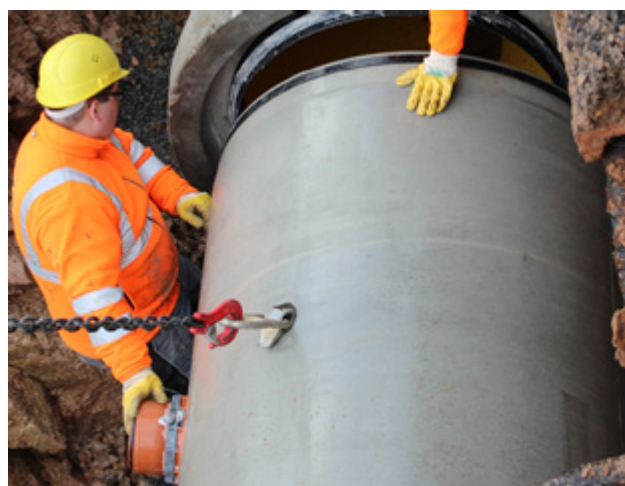
Bild 4: Anbindung eines Perfect Pipe-Stahlbetonrohres der Dimension DN 1000 an den bereits neu installierten Kanalstrang
