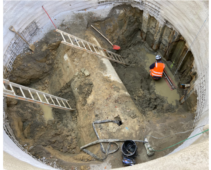
Bild 4: Der Anschluss des neuen Rohres an den nächsten Hauptsammler erfolgt in der Zielgrube. 93 m waren bis dorthin zu überwinden
