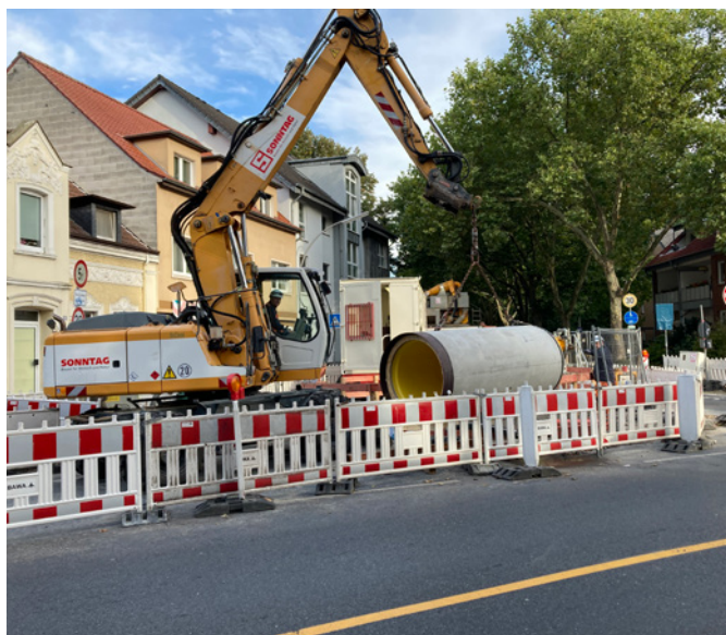
Bild 1: Dank des hervorragenden Baustellenmanagements durch das bauausführende Unternehmen Sonntag lief die Baumaßnahme ohne Störungen und wurde in der vorgegebenen Zeit beendet.
