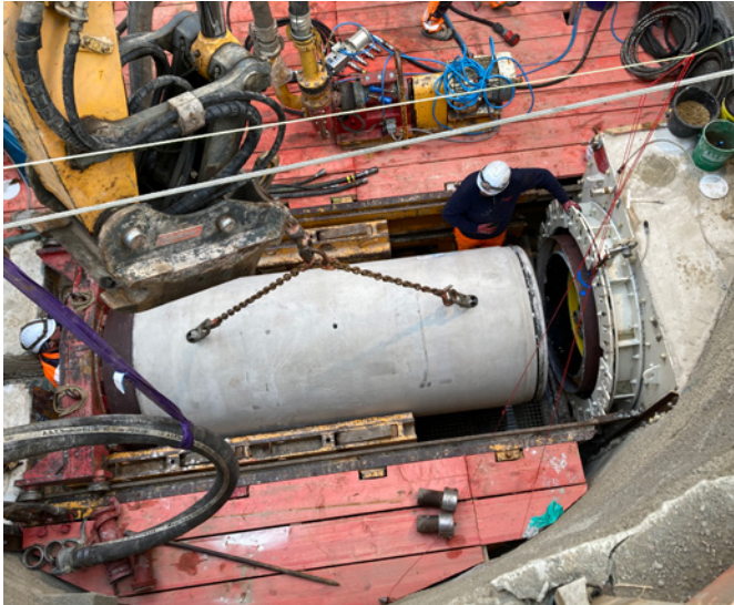
Bild 3: Das nächste Vortriebsrohr wird vorsichtig mit der hydraulischen Presse vorgeschoben und in den bereits eingebauten Rohrstrang eingeführt
