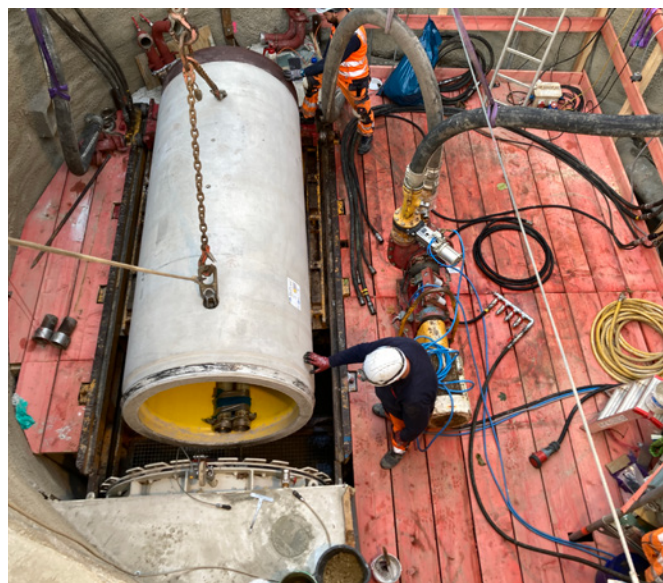
Bild 2: Absenken eines 3 m langen Vortriebsrohres in den Startschacht. Lieferbar ist das Perfect Jacking Pipe Plus derzeit in den Durchmessern DN 500, 600, 700, 800, 1000 und 1200
