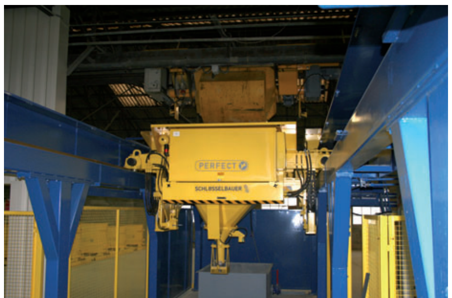
La benne béton du bâtiment voisin approvisionne également l'installation Perfect en BAP
