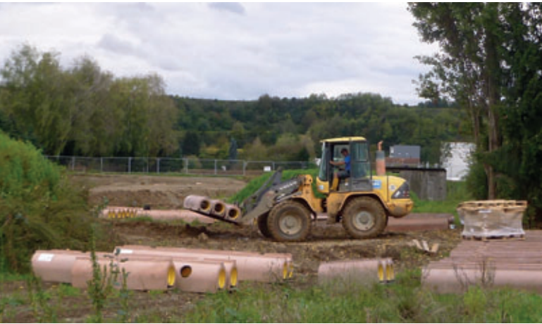
Les tuyaux sont déplacés sur le chantier à l'aide d'engins simples.
