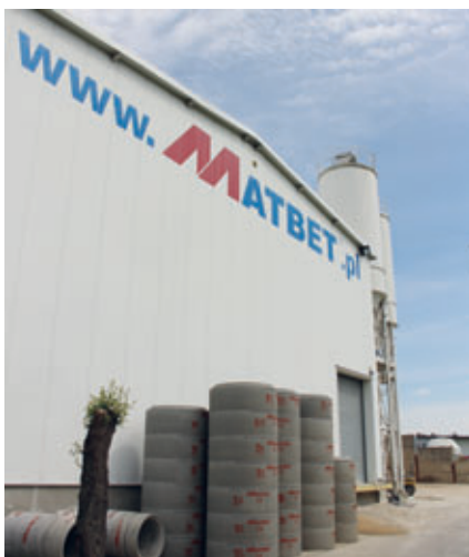
Usine de production de béton de l'entreprise Matbet à Tarnowo Podgórze, Pologne
