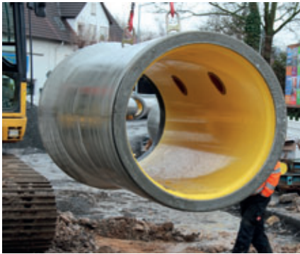
Levage d'un tuyau Perfect prêt à la pose, avec deux branchements pour entrées latérales.
