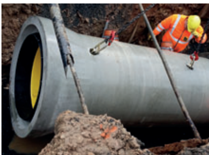
Dépôt en douceur du tuyau avant connexion à la nouvelle canalisation.
