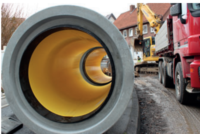
Entreposage provisoire sur le chantier de Sanderhausen à Niestetal de tuyaux Perfect en béton armé de diamètre 1000 avec connecteurs en plastique posés en usine.
