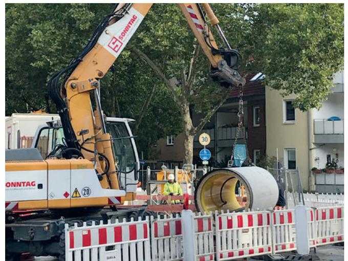
Proyecto de Datteln: elevación en zanja inicial, detalle de lubricación de bentonita de las tuberías.
