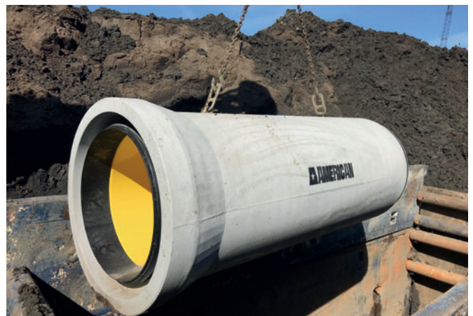
Perfect Pipe se monta en Nebraska: justo después de montar el tubo, se crea un sistema de tuberías flexibles protegido contra la corrosión.
