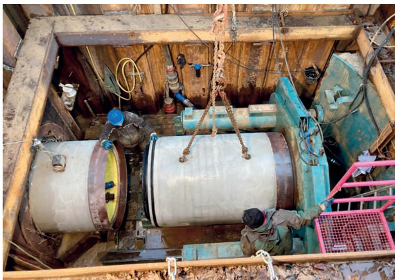
Los tubos para hincado Perfect Pipe se unen mediante conexiones de enchufe de plástico con juntas exteriores. Por una parte, estas conexiones de enchufe ofrecen flexibilidad de unión durante la instalación; mientras que, por otra, permiten prescindir de la soldadura de las uniones después de la instalación con diámetros de tubo de hasta 1500 mm.
