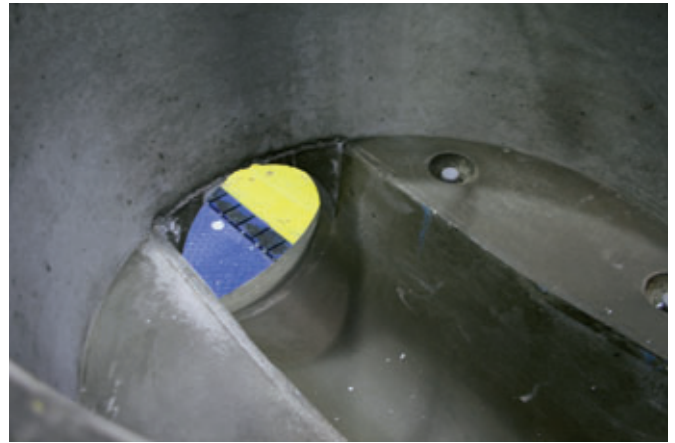
Base de pozo acabada antes del transporte para su salida hacia el almacén exterior
