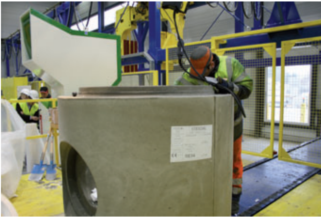
Retirada y reciclaje de los encofrados.
