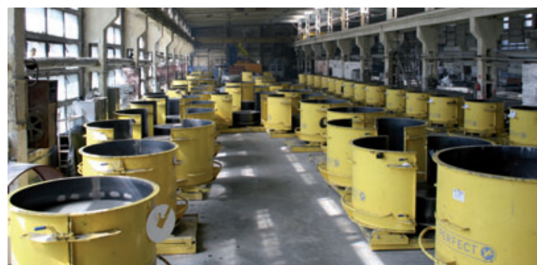
Vista de la fabricación mediante el sistema Perfect con más de 60 moldes
