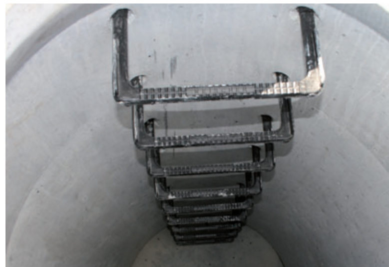
Los escalones se clavan después del desencofrado en los casquillos previstos
