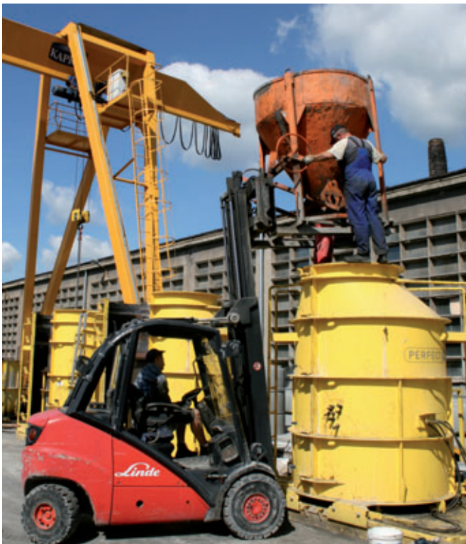
El hormigonado se realiza con una carretilla elevadora y una cubeta para hormigón. Como en el caso del sistema Perfect, suele emplearse únicamente hormigón autocompactante
