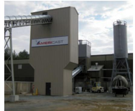
La fábrica de Ashland, en la que se ha instalado el equipo Exact1500 de Schlüsselbauer, dispone de cuatro silos de más de 60 toneladas para adiciones, así como otros dos silos para cemento y cenizas volantes. Se permite sustituir hasta un 25 % del cemento por cenizas volantes.
