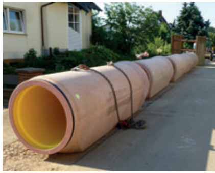
En el primer proyecto en el estado federado de Hessen se utilizan productos Perfect Pipe con el ancho nominal DN800.
