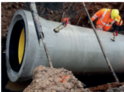
Colocación con cuidado del tubo y conexión con el nuevo tramo de canal.
