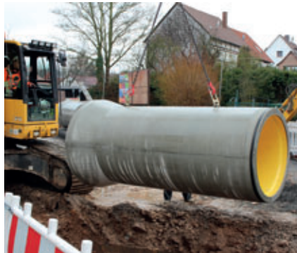
Disposición sobre la zanja con la ayuda de una suspensión de cadena fijada a dos anclajes de cabezal esférico.
