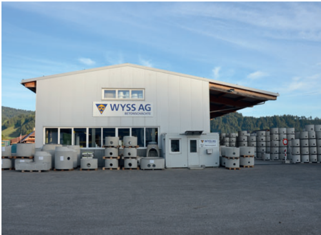
Área de producción y almacenamiento de la empresa Wyss AG Betonschächte en Schüpbach im Emmental, Suiza.
