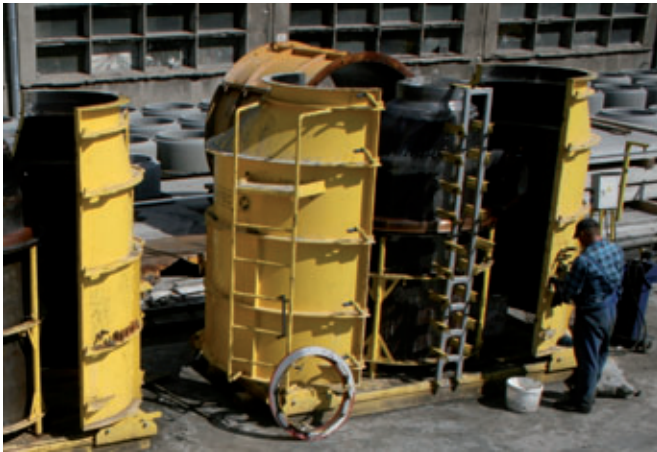
Für das exakte Setzen der Einschlaghülsen für die Steigbügel wird eine spezielle Schablone an den Formkern gehängt
