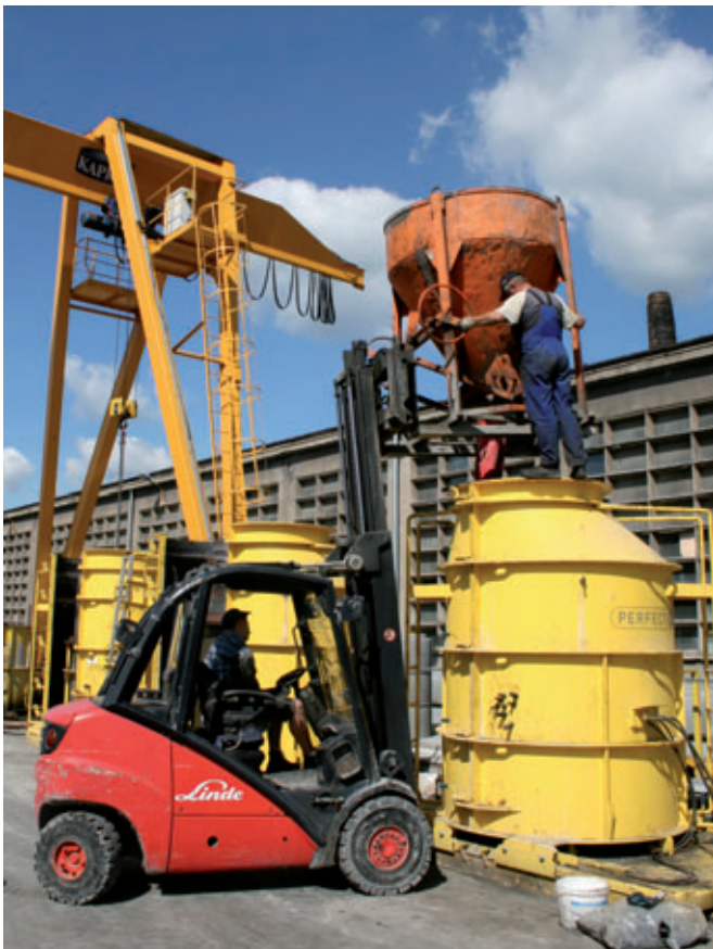
Betoniert wird mit Gabelstapler und Betonkübel; wie beim Perfect-System üblich kommt ausschließlich selbstverdichtender Beton zum Einsatz
