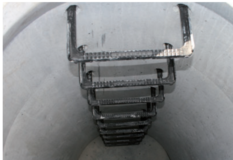
Die Steigbügel werden nach dem Entschalen in die vorgesehenen Hülsen eingeschlagen
