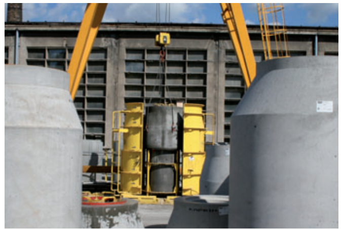
Nach einer ausreichenden Aushärtezeit werden die Formen wieder geöffnet und die Schachtkonen mit dem Kran vorsichtig aus der Form gehoben
