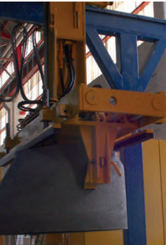
Mittels Greifer versetzt der Kran das Schachtelement
