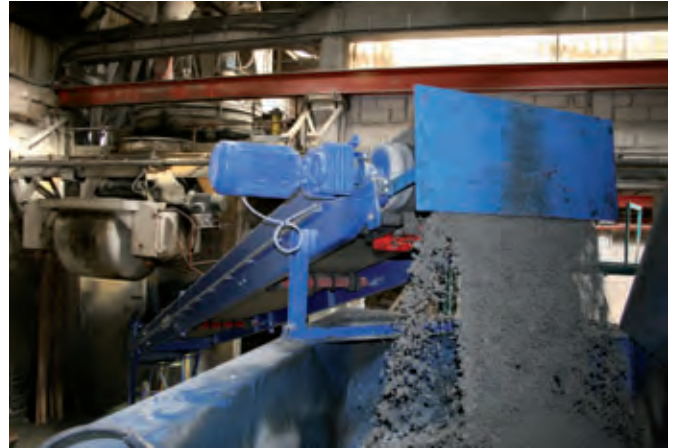
Die Betonversorgung der Magic 1501 erfolgt aus den Mixern der bestehenden Betonproduktion von Frühwald
