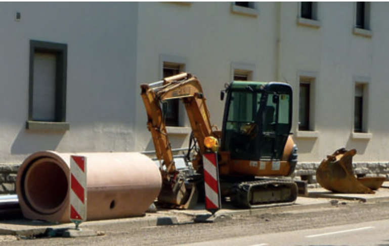
Als Grundlage für eine angrenzende Neuerschließung wurden in Achern/Baden-Württemberg Betonfußrohre DN800 eingebaut, zum Teil mit vorgefertigten Anschlüssen für sohlgleiche Seitenzuläufe.
