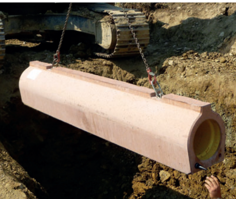
Einheben der Rohre mit fest im Beton eingebundenen Hebeankern
