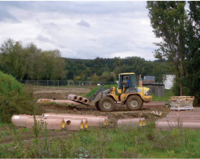
Mit einfachem Gerät werden die Rohre auf der Baustelle bewegt.
