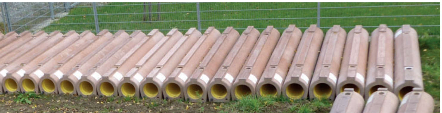
Typisches Baustellenlager Perfect Pipe DN250 in Eendingen am Kaiserstuhl
