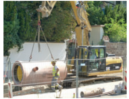
Mehrere alte keramische Rohrleitungen werden durch einen neuen Sammler DN1000 ersetzt.
