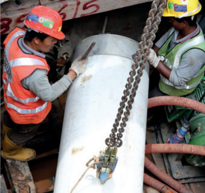
Einheben eines Rohres in den Startschacht
