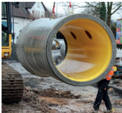
Anheben eines einbaufertigen Perfect Pipe Rohres mit zwei seitlichen Zulauföffnungen
