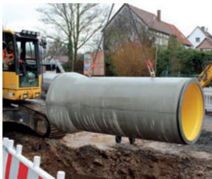
Einheben in die Baugrube unter Zuhilfenahme eines an zwei Kugelkopffankern befestigten Kettengehänges
