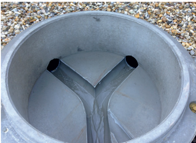
Mittels Perfect-Verfahren monolithisch gefertigte Betonbrunnenstube für den Einsatz als Quellfassung in Regenhütte, Gemeinde Bayerisch-Eisenstein
